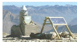
Une station GPS du réseau REGAL
